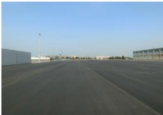
新たに開設した中島ヤード
